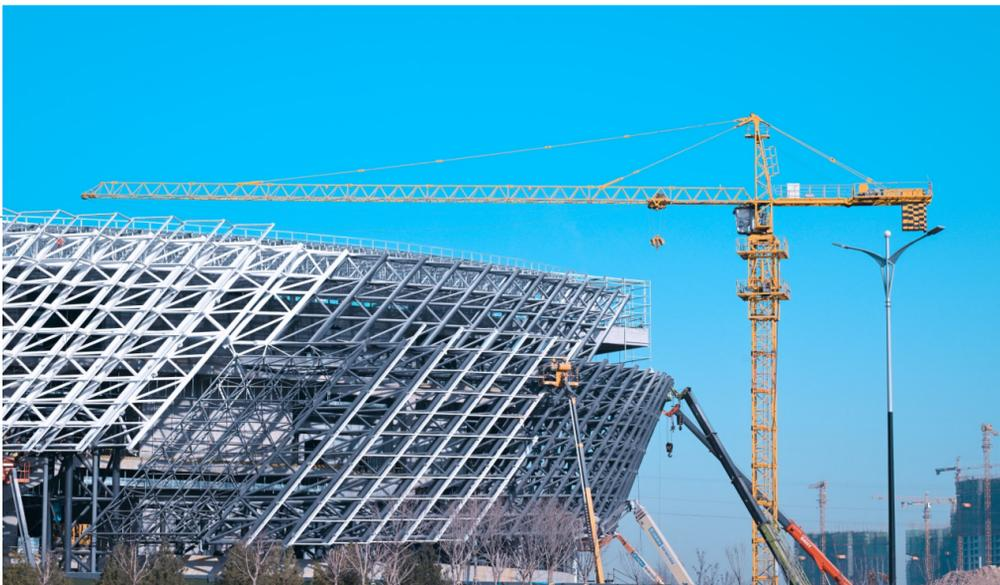
近日,在我市新图书馆和档案馆建设工地记者看到,施工人员正在对建筑外立面进行砌筑钢结构安装。今年以来,项目施工方紧盯项目任务进度,紧扣时间节点,加大人力物力投入,确保项目高标准、高质量进行。据了解,该场馆预计今年7月底竣工,届时将成为我区又一地标性建筑。
